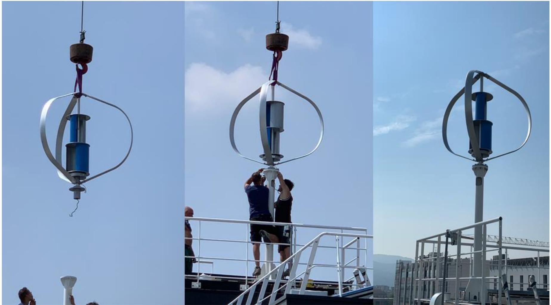
El poste del aerogenerador de eje vertical debe respetar el diseño de la brida de conexión del propio generador, es posible realizar postes para cubiertas planas o postes a diseñar después de la evaluación.
